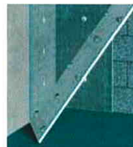
Enkel liming av plater direkte på mur
